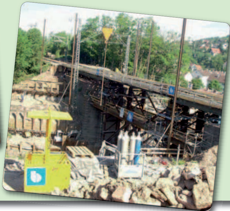
... SCHIENENFAHRWEGE, Hilfsbrücken und deren Hinterfüllbereiche sowie Baubehelfskomponenten. Das Verfahren kann aber auch beim im Bestand angewendet werden.
